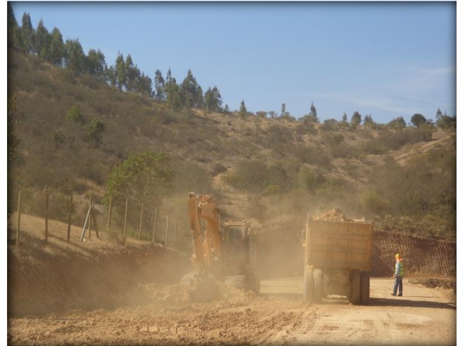
Movimiento de tierras, Km 30.700.
