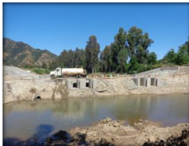
Vista panorámica, Bocatoma Canal Lolol Sur.
