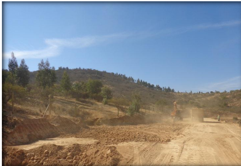
Movimiento de tierras, Km 30.750.
