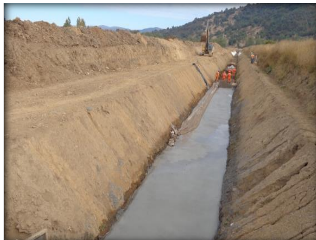
Hormigonado de radier, Km 0.200.
