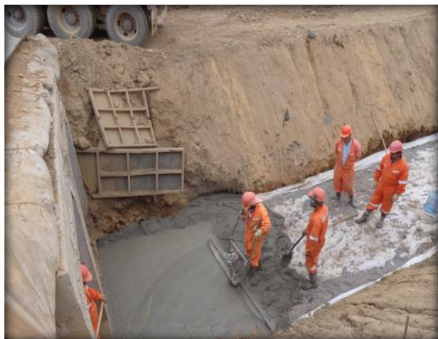
Hormigonado de radier, Km 0.090.
