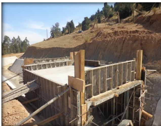
Construcción de paso predial, Km 13.760.
