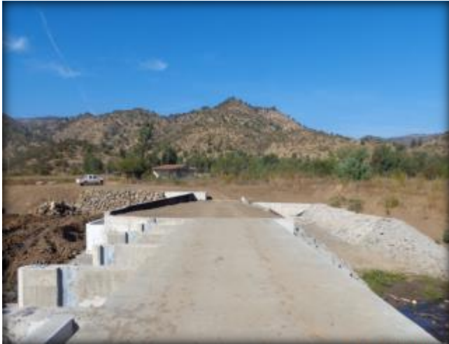
Losa de la barrera frontal de la bocatoma.
