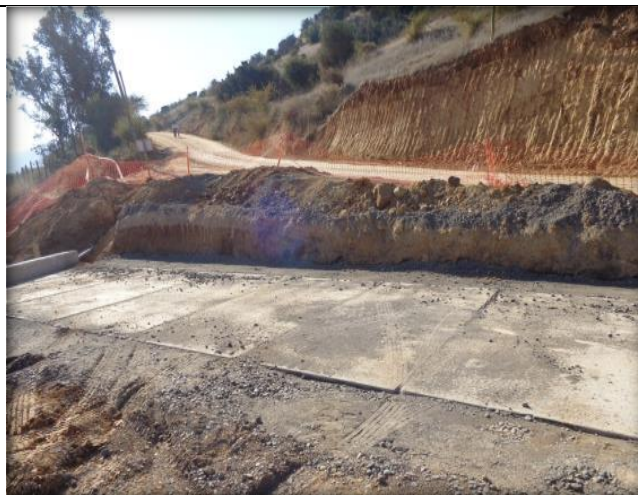
Obra de Arte N° 1, km 15.560.
