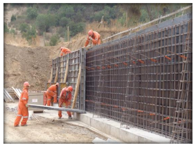
Moldaje de muro sobre estero Callihue, Km 0.580.
