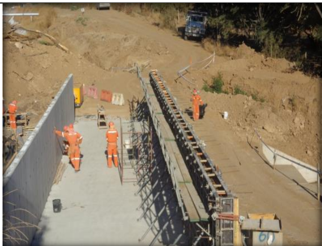
Moldaje para hormigonado en estero Callihue, Km 0.580.
