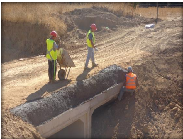
Revestimiento en talud de paso predial, Km 0.600.
