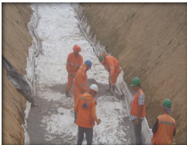
Colocación de geotextil para sello de radier, Km. 0.250.
