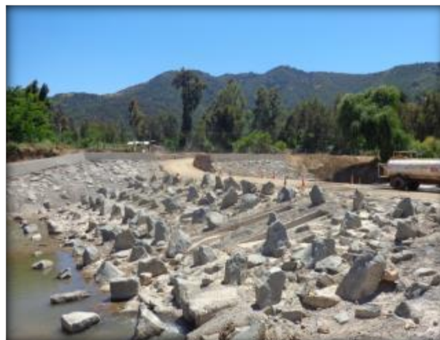
Vista panorámica, Bocatoma Canal Lolol Sur, enrocado consolidado rugoso.
