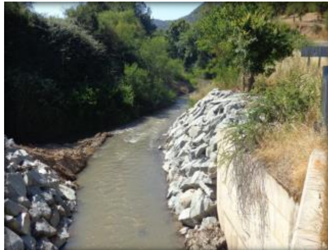
Enrocados de protección finalizados, aguas arriba y aguas abajo del puente María Rosa.
