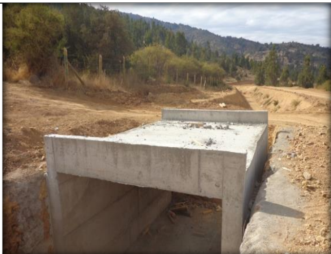
Construcción de paso predial, Km 15.270.
