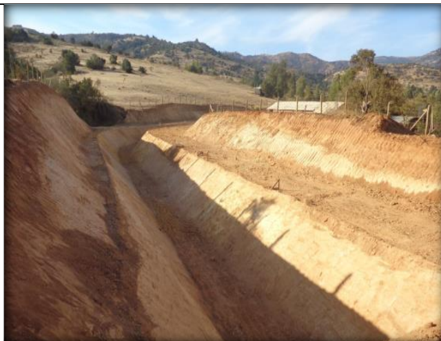
Corte de canal, Km 21.300.
