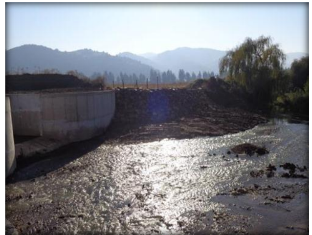
Enrocado de protección aguas arriba de la bocatoma.
