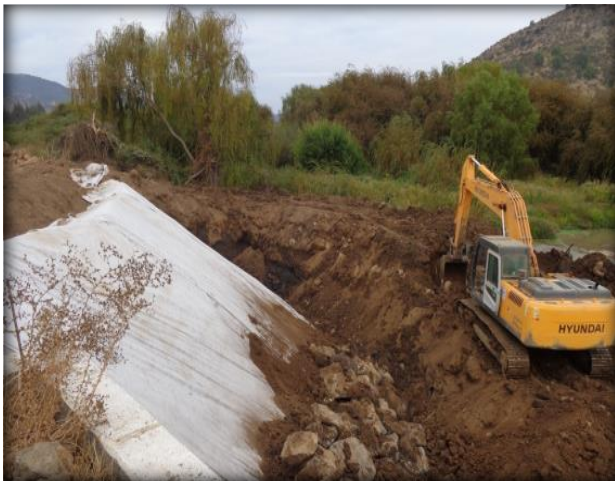
Enrocado de protección aguas arriba de la bocatoma.
