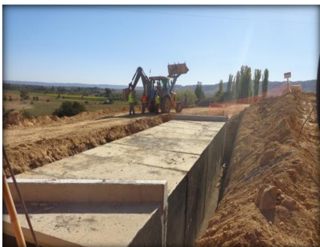
Rellenos estructurales en Obra de Arte N° 1, Km 15.560.
