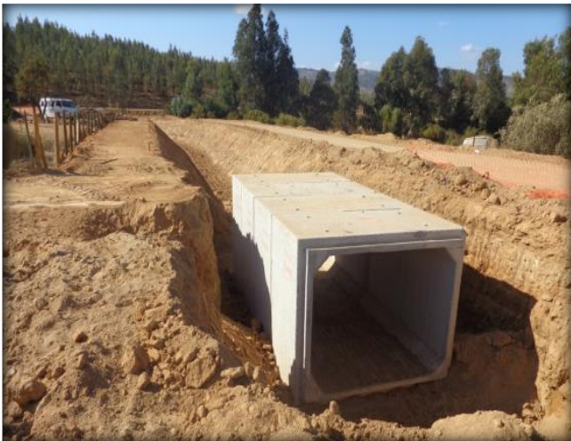
Construcción de paso predial, Km 29.990.
