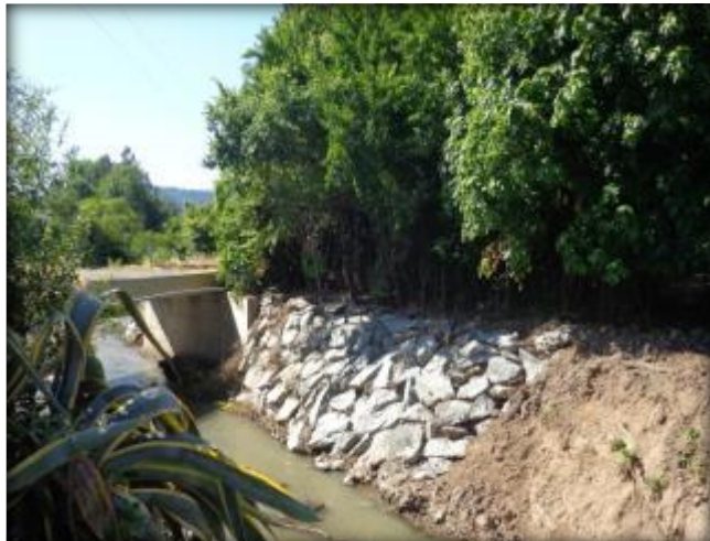
Enrocados de protección finalizados, aguas arriba y aguas abajo del puente María Rosa.
