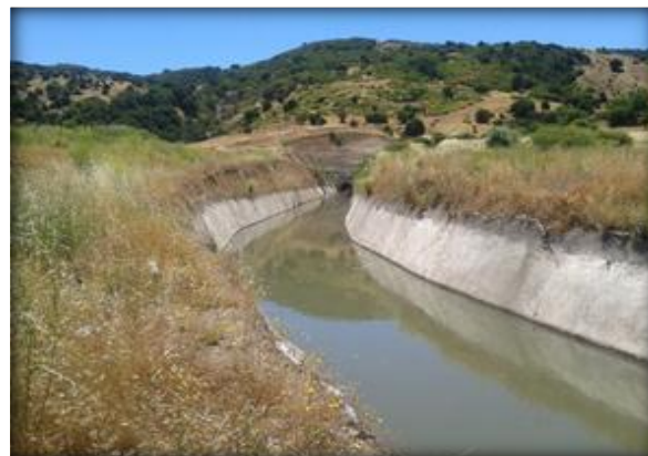
Sector de salida poniente Túnel La Lajuela.
