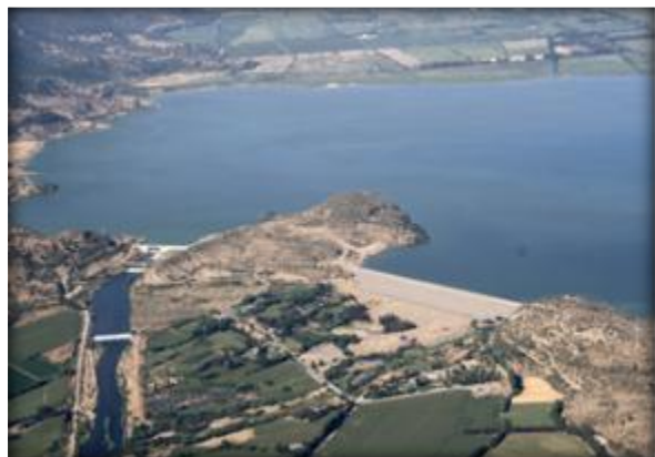
Zona de Presa y Embalse Convento Viejo.
