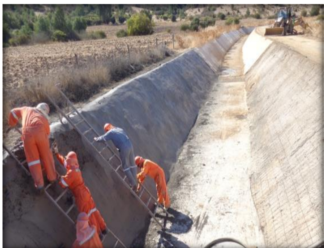
Hormigonado de talud, Km 3.960.
