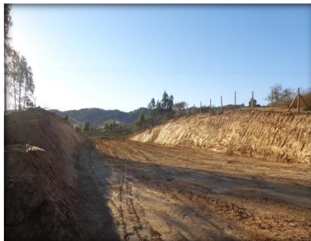
Corte en terreno, Km 26.740.
