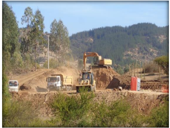
Corte en terreno, Km 26.700.
