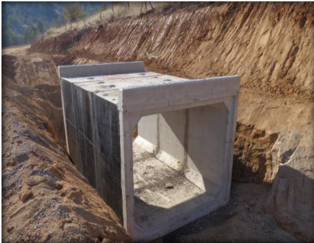
Construcción de paso predial, Km 24.400.
